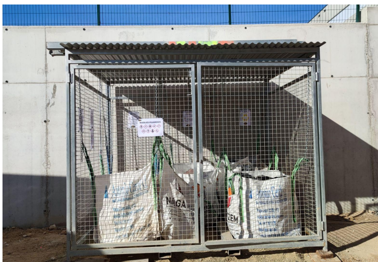
Punto limpio Residuos peligrosos obra ELIT
