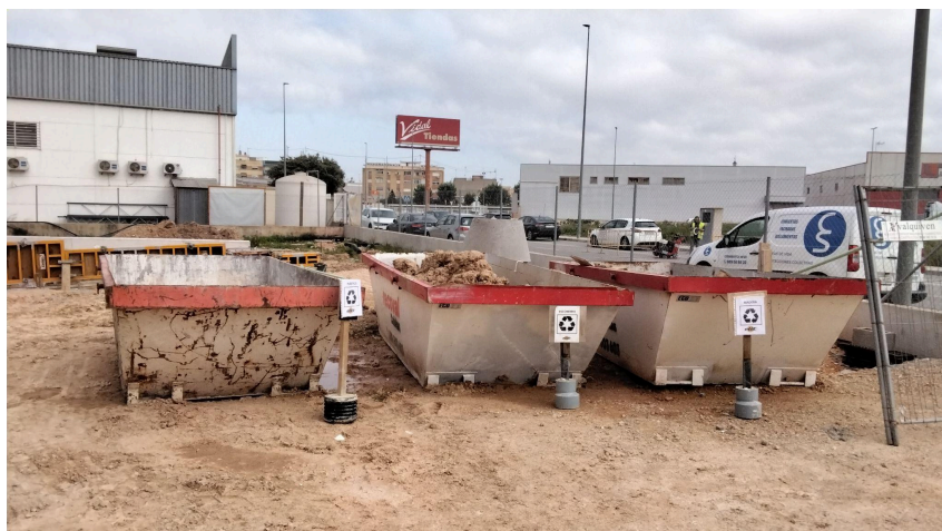
Punto limpio de RNP en una obra de ELIT
