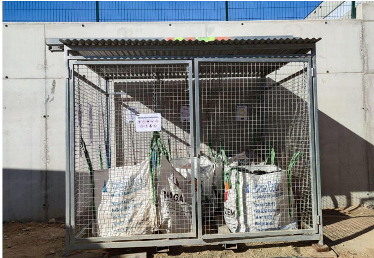
Punto limpio Residuos peligrosos obra ELIT
